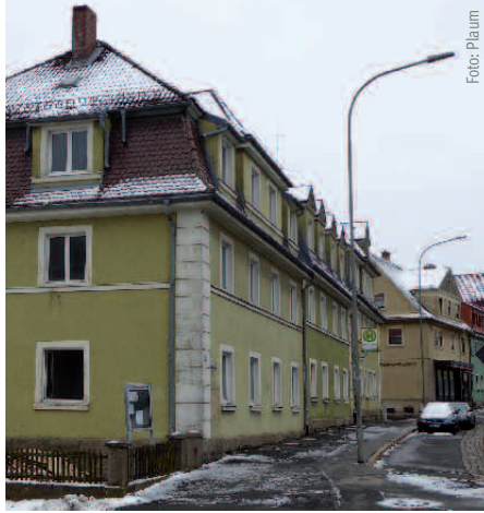
Kernsanierung in der Rehauer Straße schafft neuen Wohnraum
