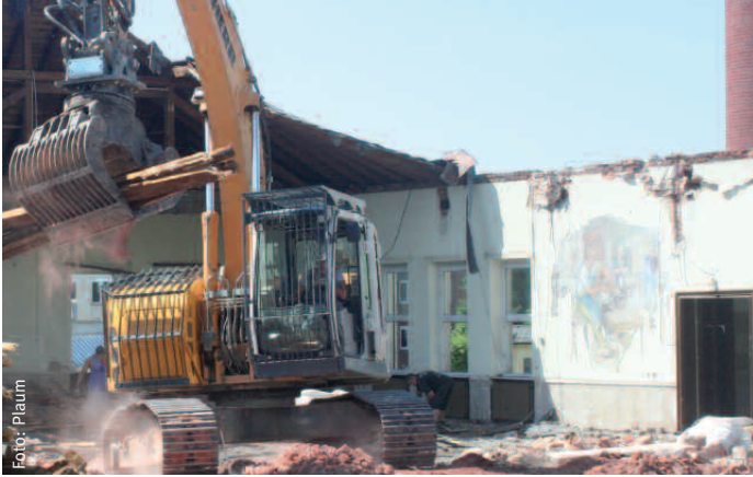
Altes weicht Neuem. In Schwarzenbach a. d. Saale entsteht ein Rossmann-Vollsortimentmarkt, das frühere Winterlingpfortnerhaus mit Kantine wird abgerissen.
