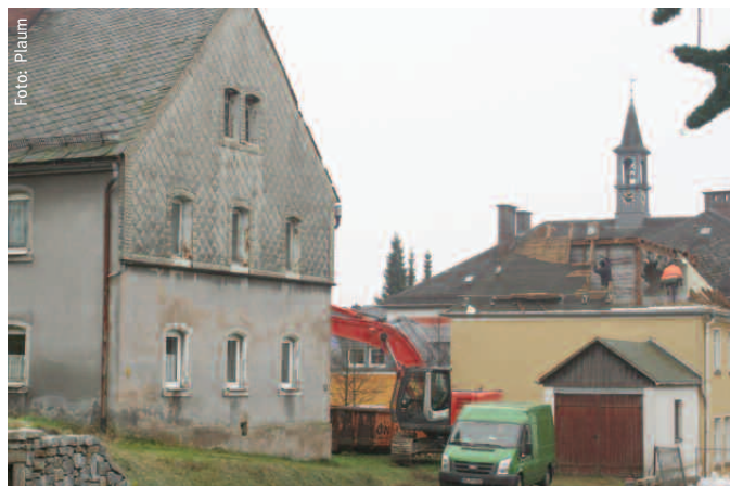
„Neue Mitte“ in Röslau wird attraktiver: Rückbau der ehemaligen Zahnarztpraxis.
