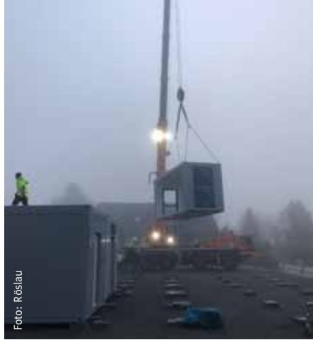
Container als Ausweichlösung machen den Erweiterungsbau des Kindergartens in Röslau möglich
