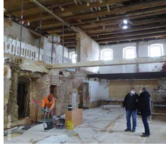
Baustelle Goldner Löwe in Kirchenlamitz
