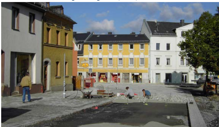
Sanierung Bahnhofstraße 2007 (Plaum)
