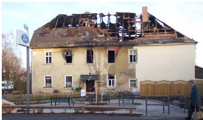
Brandruine vor Bau Egerauenpark 2000 (Stadt Marktleuthen)
