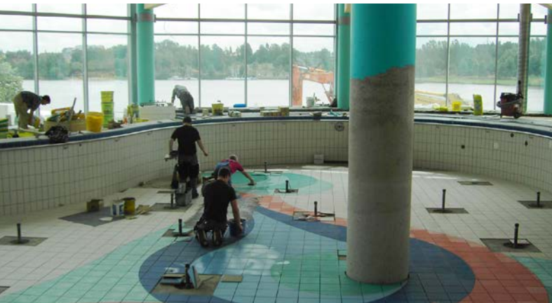
Bau Kurzentrum Bad Weißenstadt am See 2007 (Plaum)
