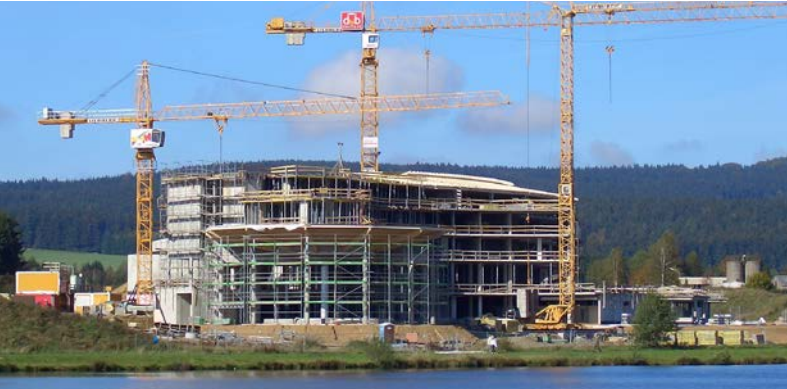
Bau Kurzentrum Bad Weißenstadt am See 2007 (Gesell GmbH)
